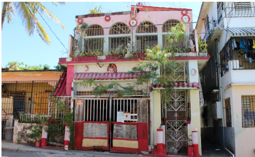
Maisons consolidées proches du cours d'eau dans le district spécial de planification du Caño Martín Peña . ©PIERRE ARNOLD, FÉVRIER 2017
